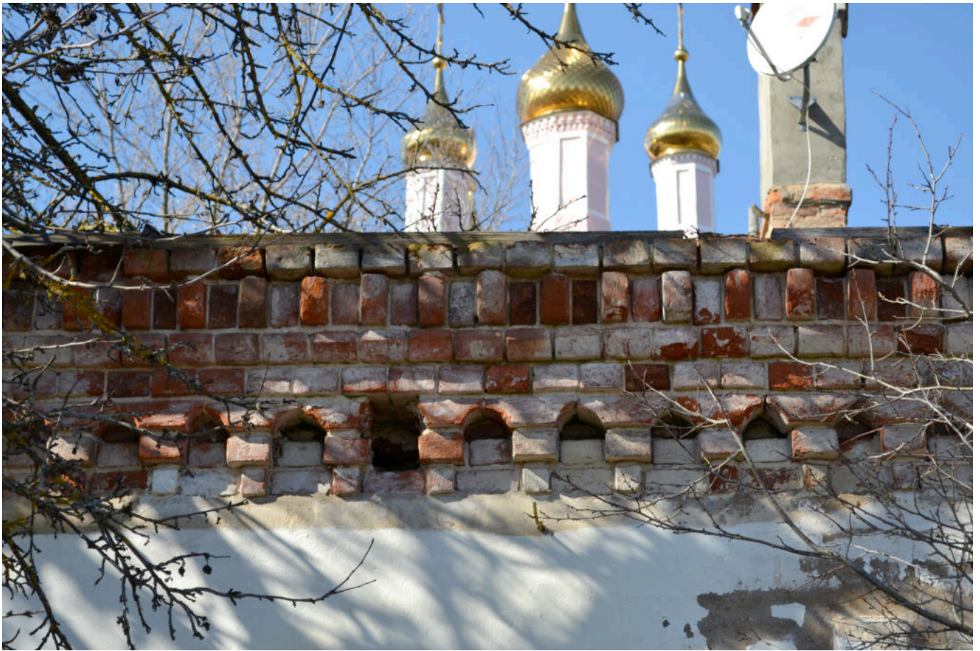
Фото 15. Карниз южного фасада.
