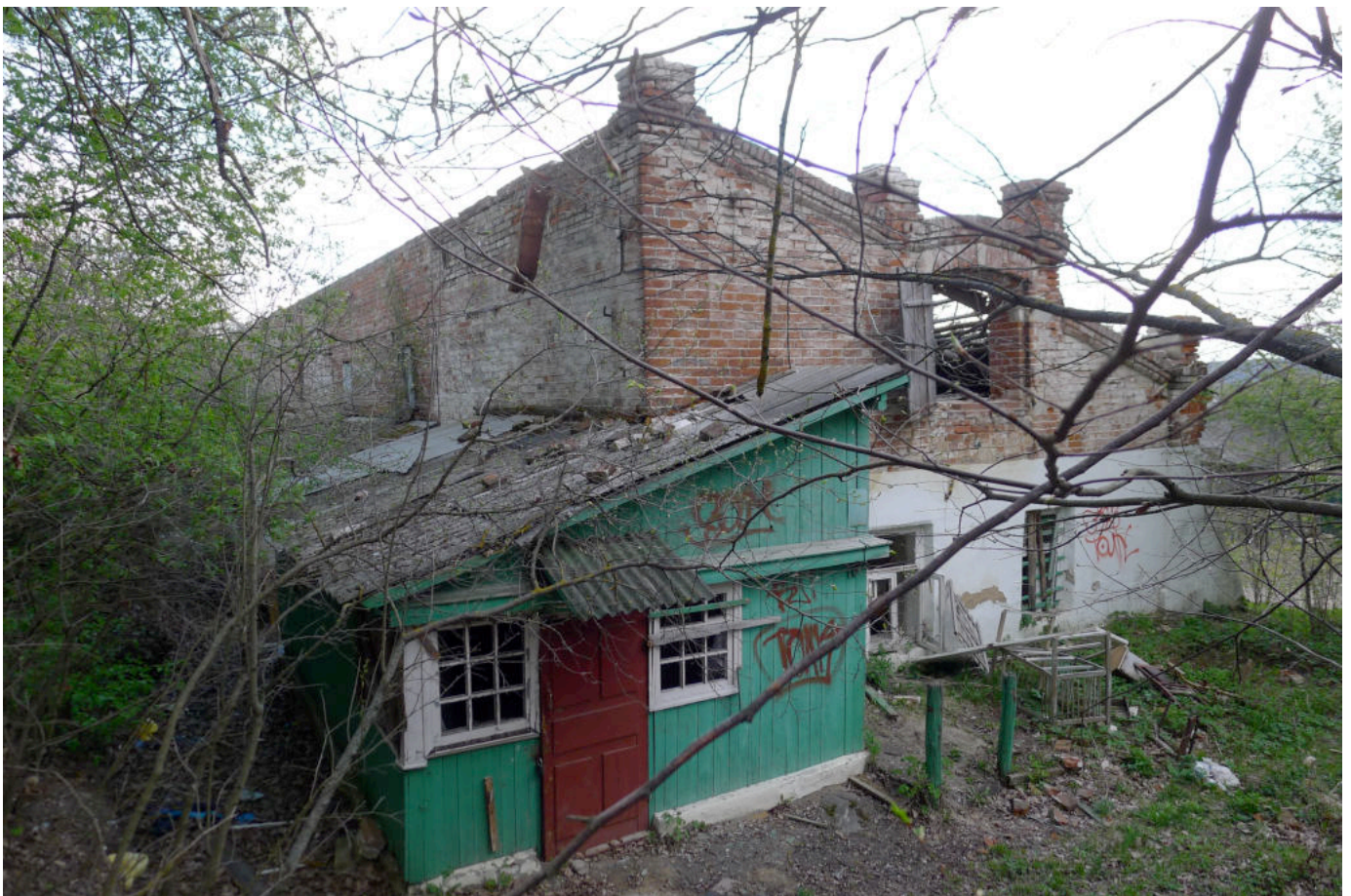
Фото 18. Конюшня. Вид с северо-запада.
