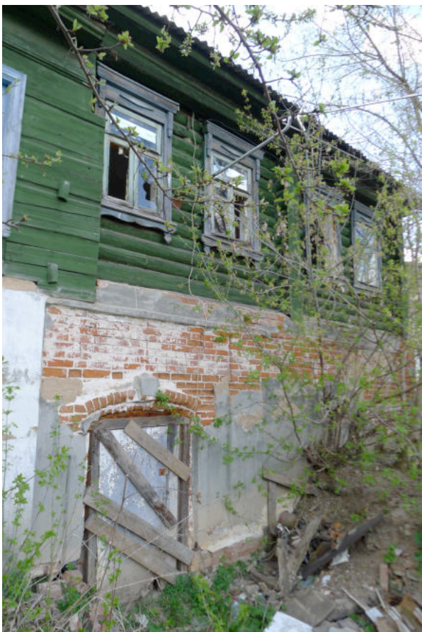
Фото 5. Главный дом. Восточная часть основного объема. Вид с юго-востока.
