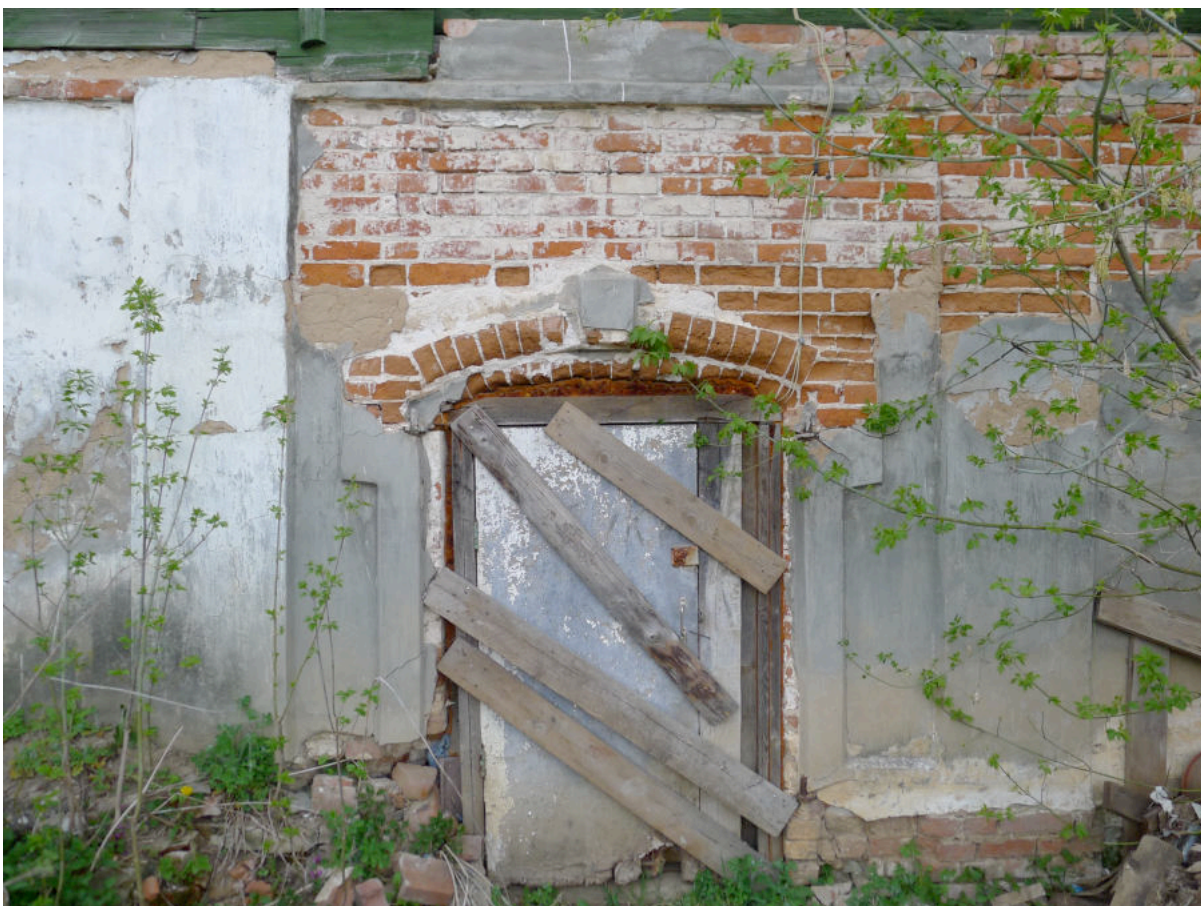
Фото 6. Главный дом. Вход в середине южного фасада.
