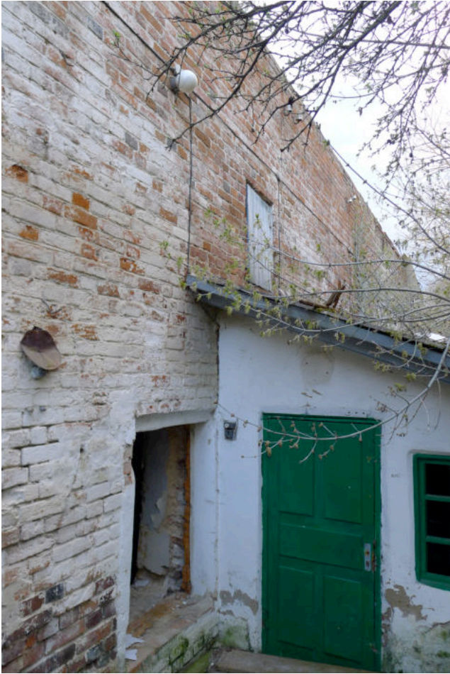
Фото 19. Северная стена конюшни.
