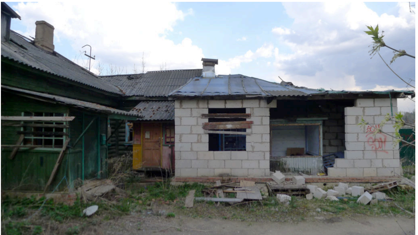
Фото 10. Главный дом. Вид с севера. Слева восточное крыло.
