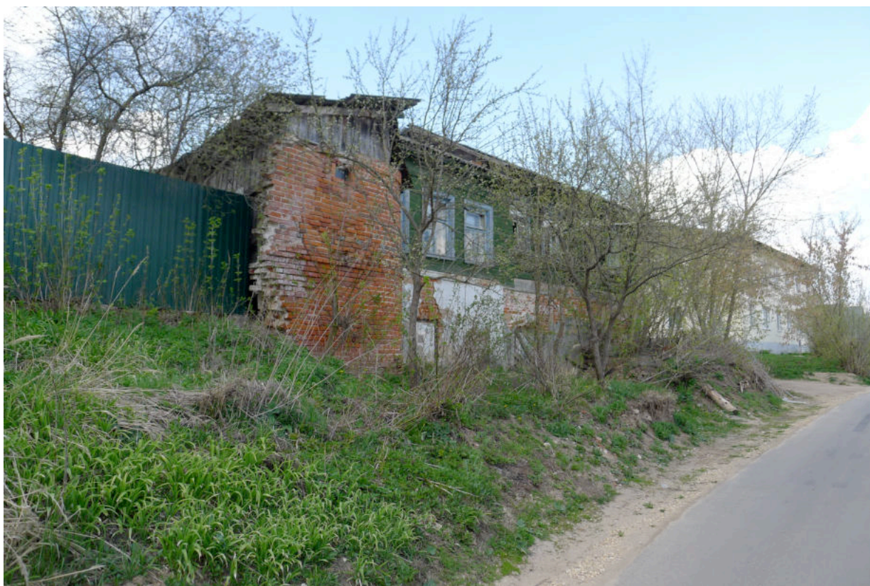
Фото 2. Вид главного дома с юго-запада.
