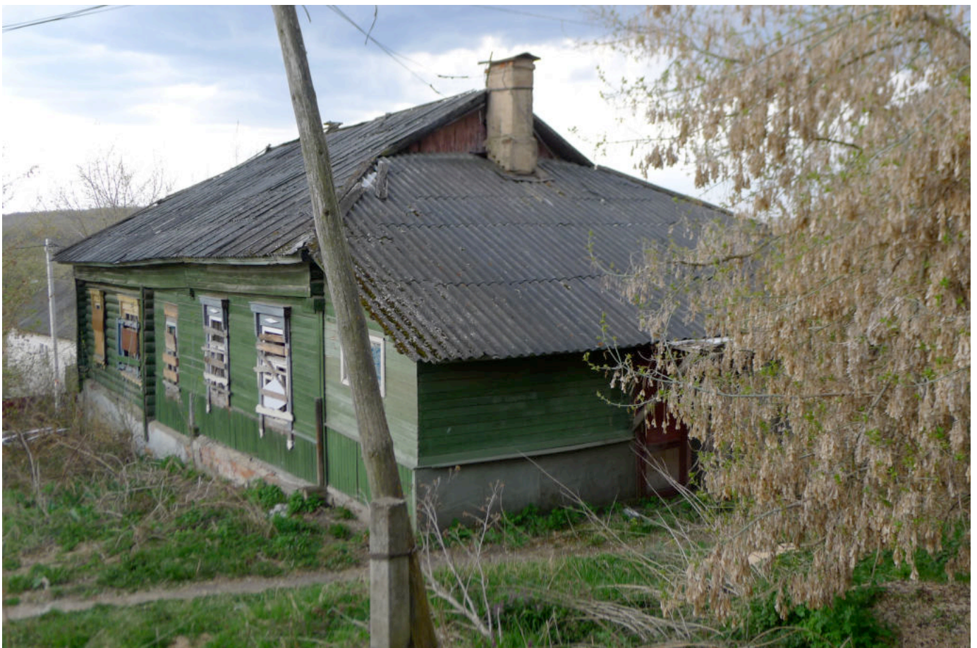
Фото 8. Главный дом. Восточное крыло. Вид с северо-востока.
